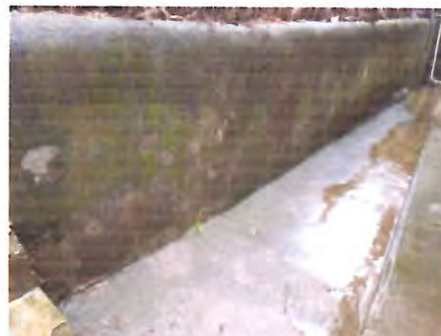
Foto 2: Reparación de fisuras y grietas en la estructura, instalación de refuerzos de acero y perforación para instalacion de tubería para drenaje de agua acumulada
