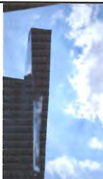
Foto1: Sustrución de canales para evacuación de aguas pluviales, con su respectivo anclaje: canal sostenido por pescantes metalicos, incluyendo sus bajadas de agua
