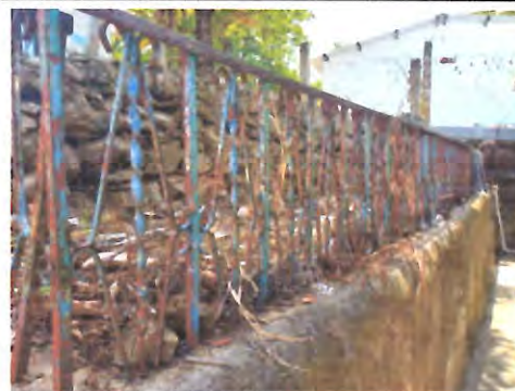
Foto 4: Sustrución de barandales metálicos, incluyendo fijaciones, pintura y soldaduras.
