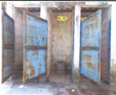
Foto 3: Suministro e instalación de puertas metálicas para sanitarios.
